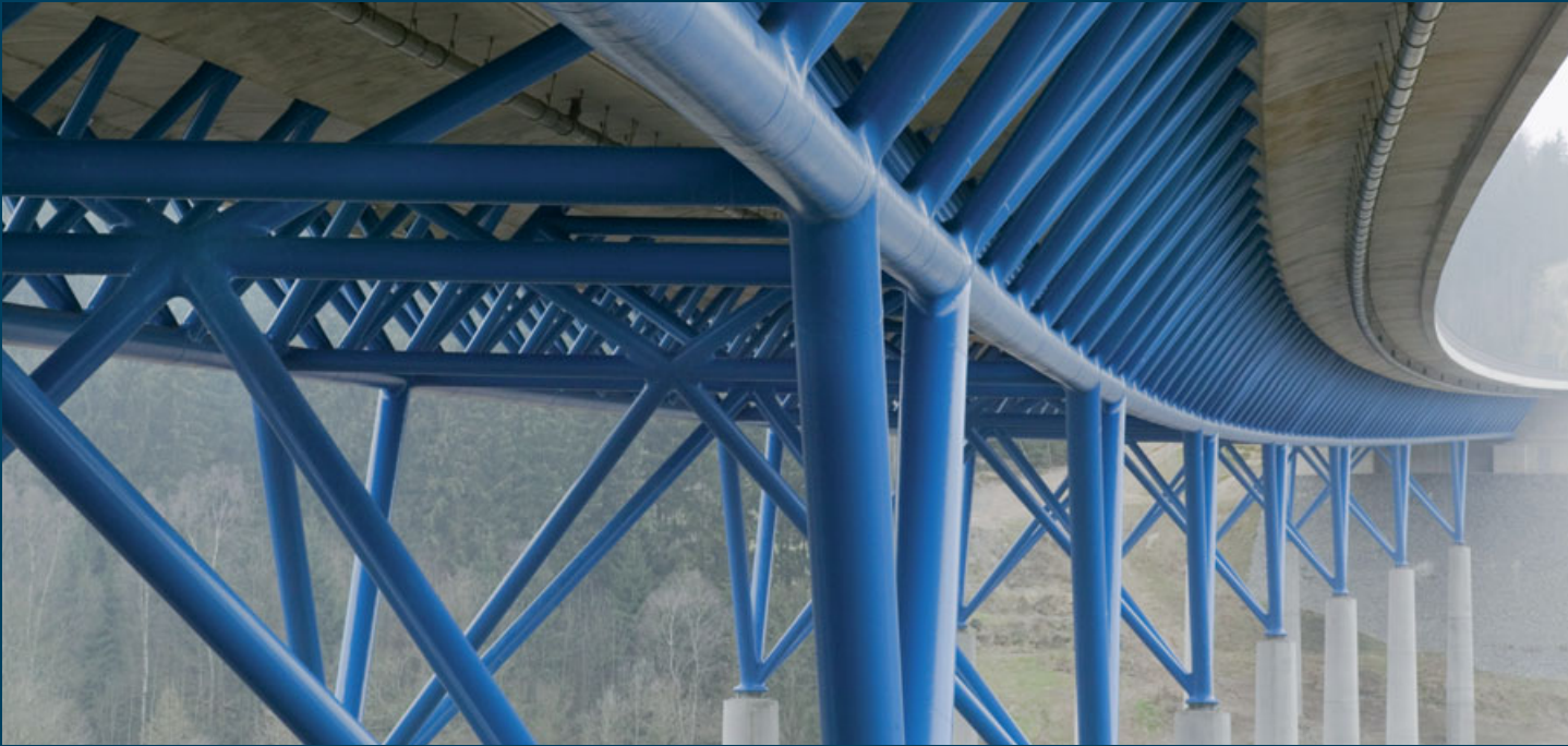
Talbrücke St. Kilian
