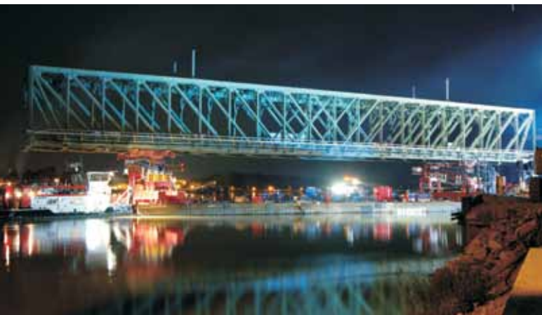
Demontage altes Tragwerk
